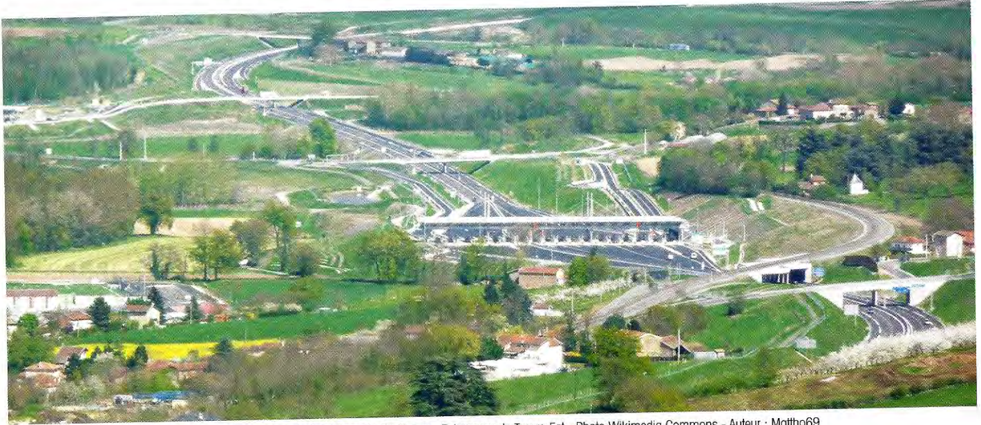
A89 - Barrière de péage de Saint-Romain-De-Popey - Echangeur de Tarare-Est - Photo Wikimedia Commons - Auteur : Mattha69
